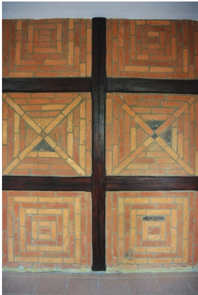
Goczałkowice-Zdrój, dawny Kurhaus, ul. Uzdrowska 54, ok. 1862 r. Elewacja wschodnia skrzydła północnego budynku (obecnie znajdująca się wewnątrz budynku). Dekoracyjne wypełnienie ceglane pól między elementami drewnianymi, fot. Maria Kołek
