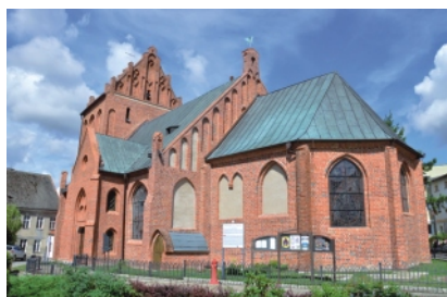
Karlino. Kościół pw. św. Michała Archanioła, fot. Krystian Zalewski
