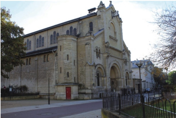
Kościół Notre Dame du Travail w Paryżu. Widok fasady i elewacji północnej, fot. Catherine Luscinski
