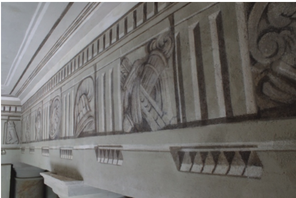
Pałac w Dobrzycy. Fragment sklepienia. Stan po konserwacji, fot. Robert Rogal
