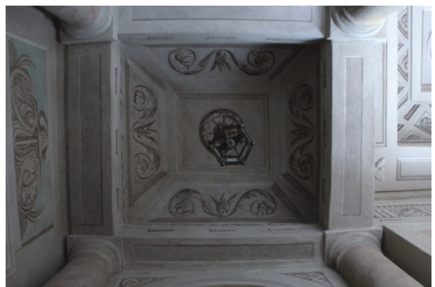
Pałac w Dobrzycy. Widok sklepienia. Stan po konserwacji, fot. Robert Rogal
