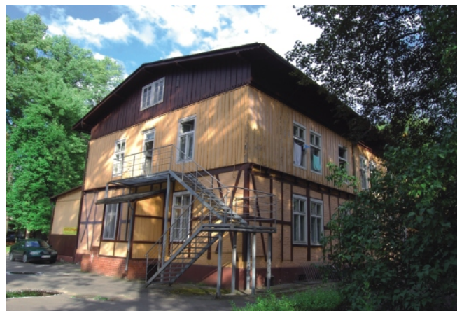
Goczałkowice-Zdrój, dawny Kurhaus, ul. Uzdrowska 54, ok. 1862 r. Elewacja północna i zachodnia skrzydła północnego, fot. Maria Kołek
