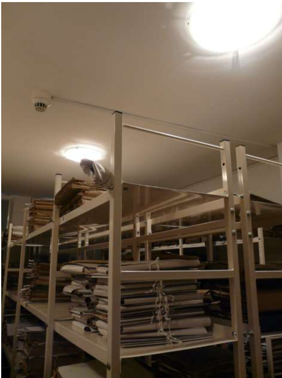
Fot.4. Lampsy żarowe usytuowane zbyt blisko obiektów, emitujące promieniowanie podczerwone w magazynie trzecim. Fot. Rafał Białkowski.
