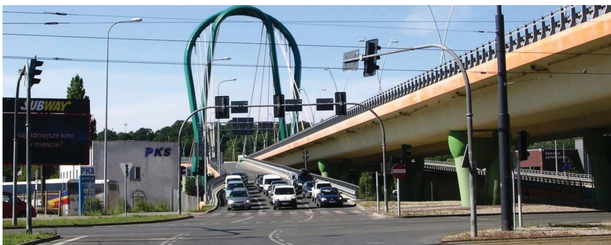
Ryc. 68. Wątpliwej jakości estetycznej konstrukcja pylonu mostu wantowego
