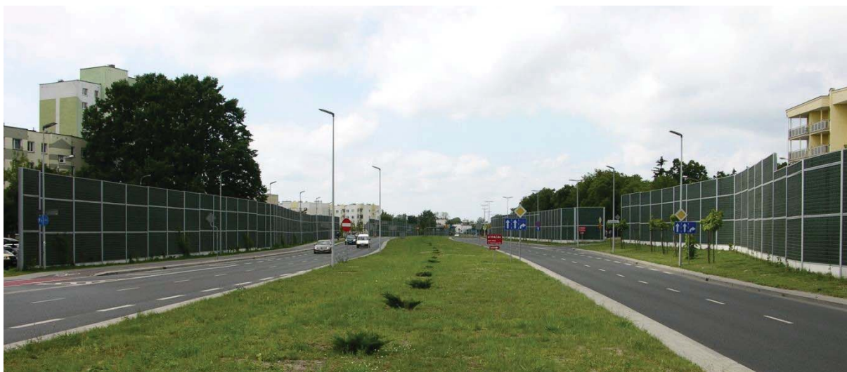
Ryc. 70. Miejski „tunel” ekranów dźwiękochłonnych
