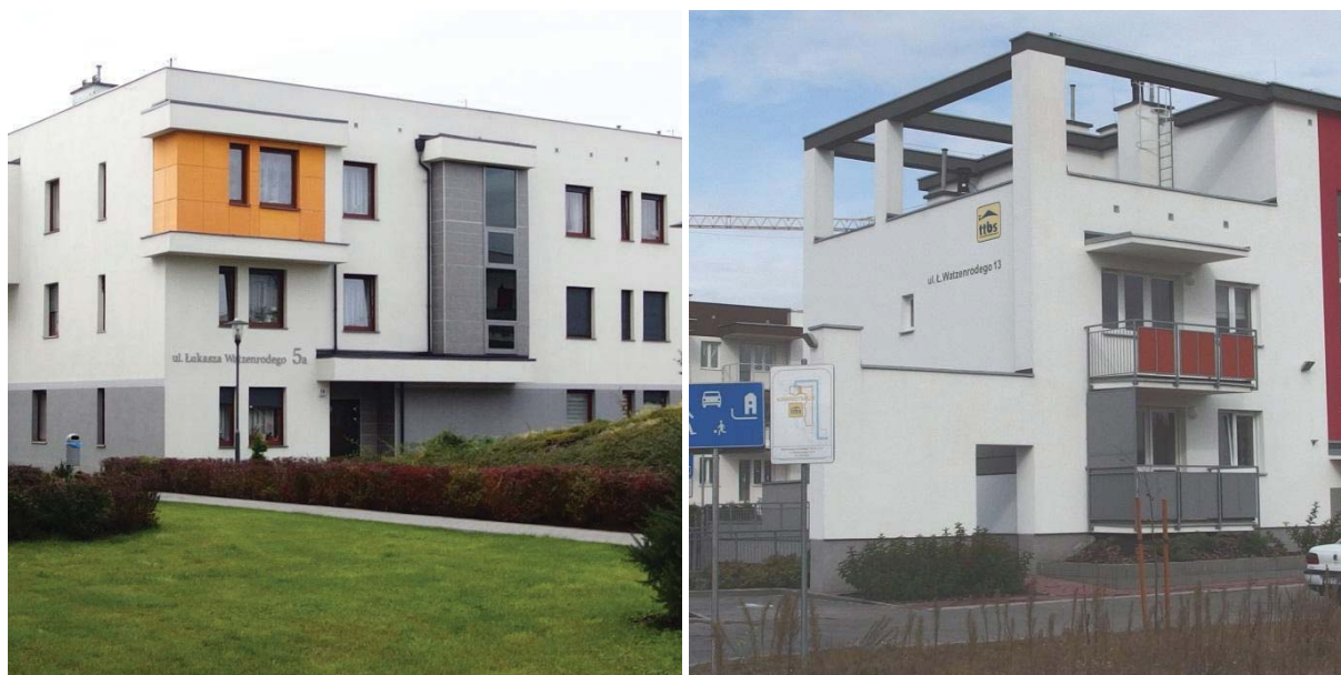
Ryc. 87. Po lewej – jeden z budynków Osiedla JAR w części wybudowanej przez dewelopera i należącej obecnie do wspólnoty mieszkaniowej; po prawej – budynek na Osiedlu JAR w części wybudowanej przez TBS
