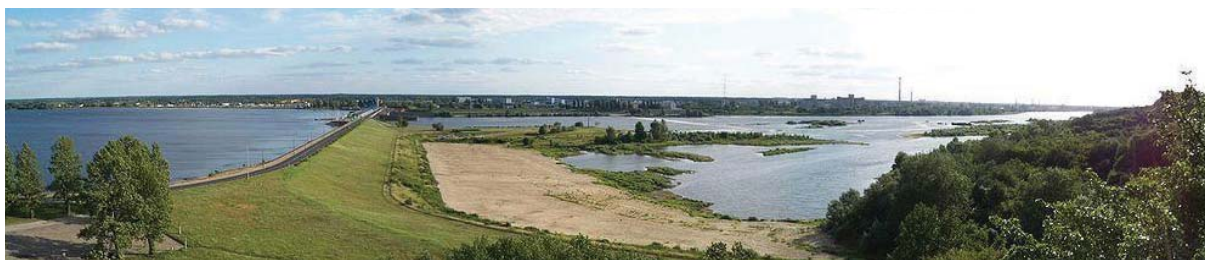
Ryc. 82. Elektrownia wodna we Włocławku
