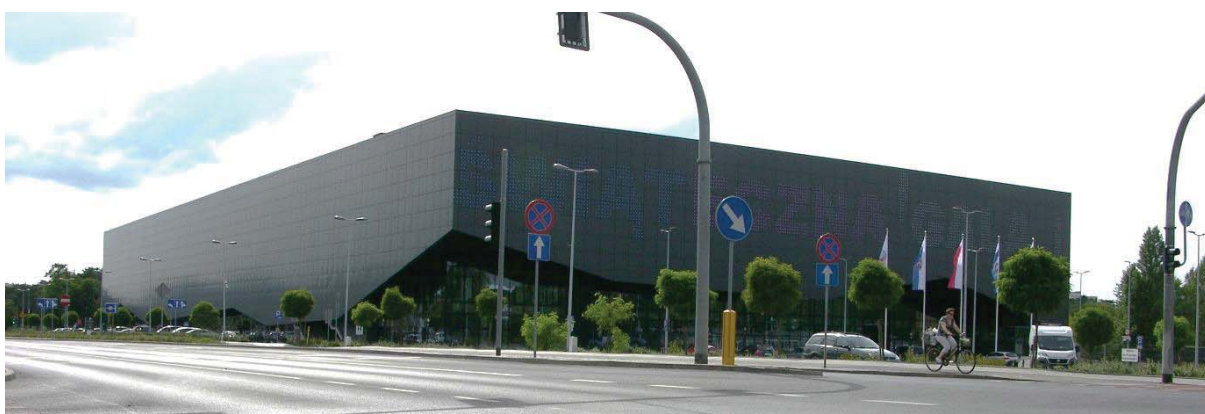
Ryc. 66. Hala sportowa wraz z parkingiem, posadowiona ok. 0,9–1,5 m poniżej poziomu ulicy
