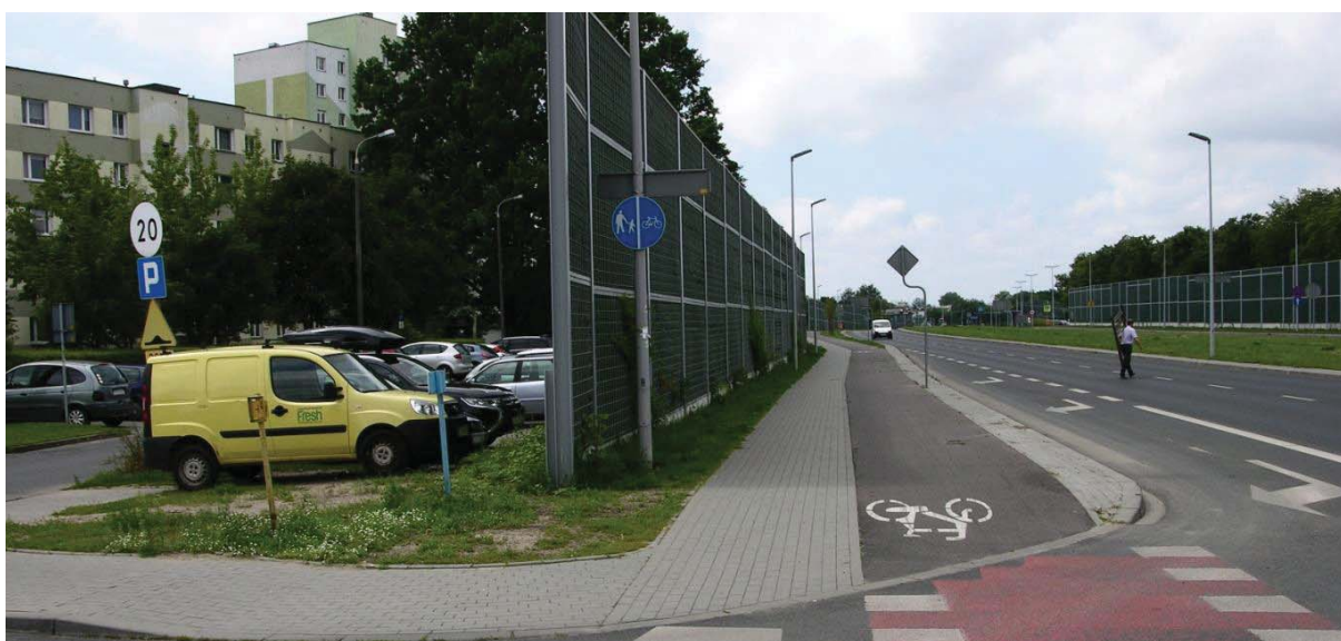
Ryc. 71. Miejski „tunel” ekranów dźwiękochłonnych, tworzący od strony osiedla swoiste mieszkaniowe getto. Chodnik i ścieżka rowerowa po uciążliwej stronie ulicy
