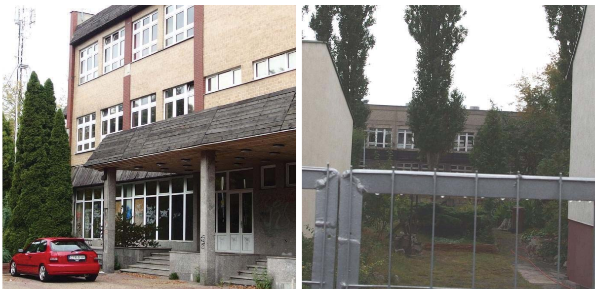
Ryc. 86. Po lewej – budynek po TORPO, po prawej – widok na budynek TORPO z perspektywy ulicy między domkami jednorodzinnymi
