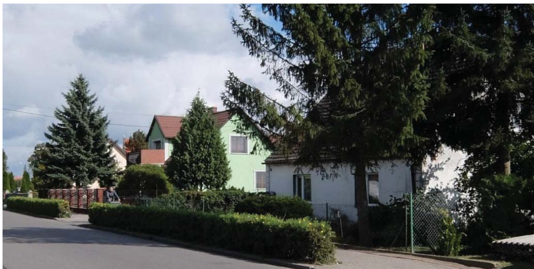
Ryc. 100. Nowa infrastruktura drogowa Kęsowa – drogi i chodniki po inwestycjach rewitalizacyjnych
