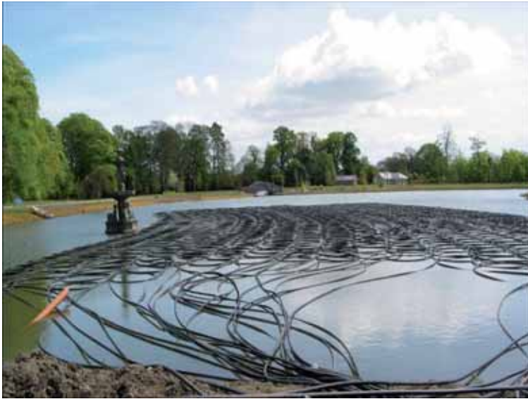
Rys. 5. Wymiennik ciepła zatopiany w jeziorze [10]
