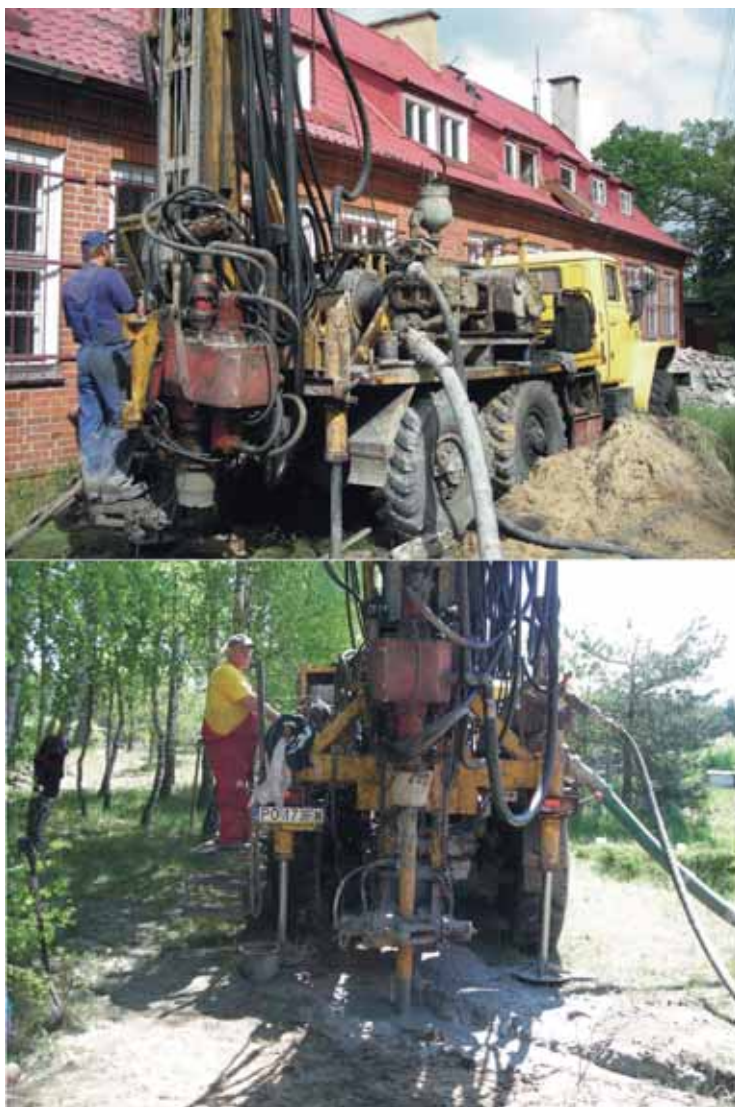
Rys. 2. Wykonywanie jednego z odwiertów dolnego źródła ciepła [6, 8]
