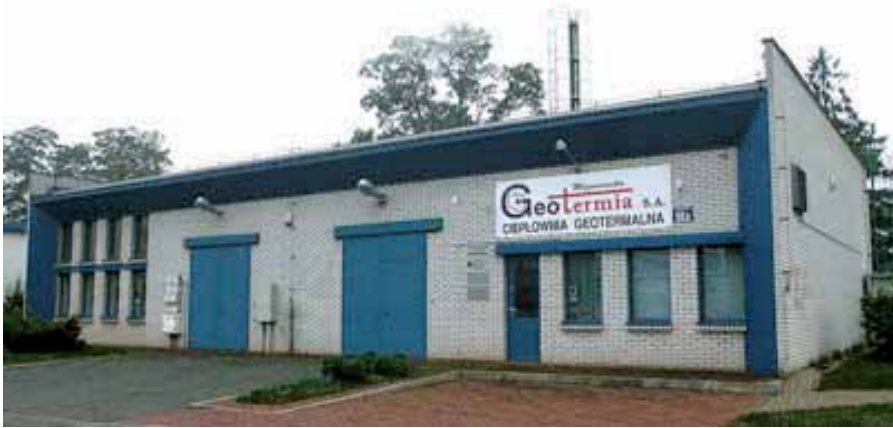
Rys. 12. Geotermia Mazowiecka (fot. G. Piechota)
