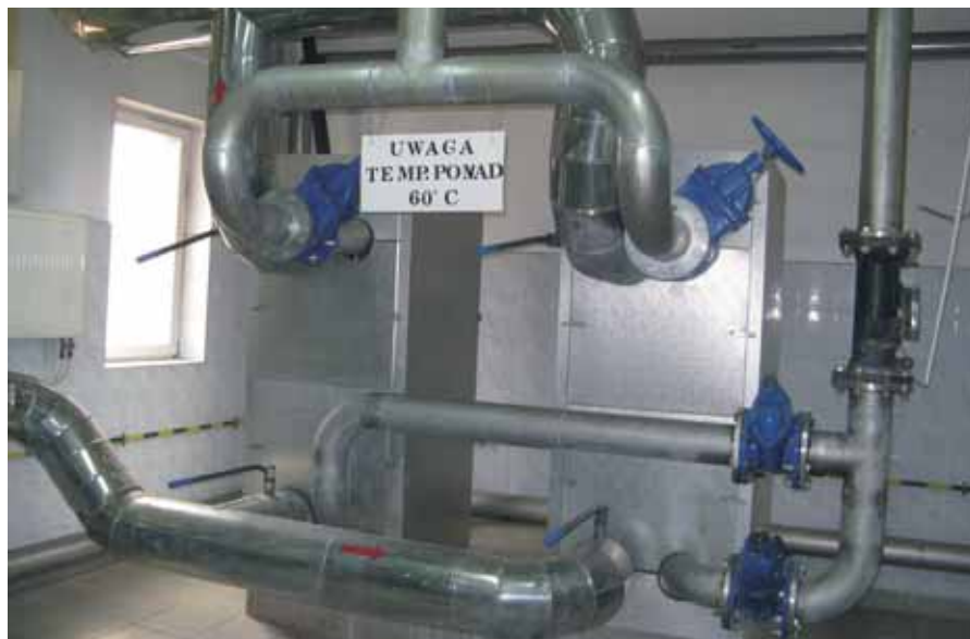
Rys. 18. Wymienniki ciepła, Uniejów (fot. B. Igliński)
