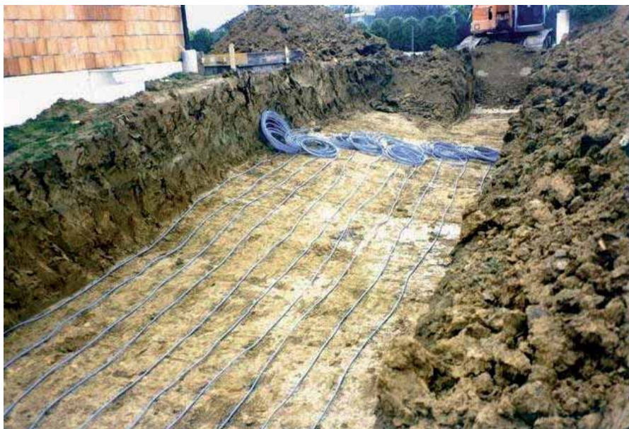
Rys. 8. Zakładanie poziomego gruntowego wymiennika ciepła [10]
