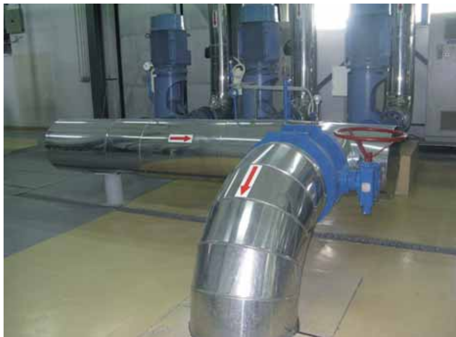
Rys. 3. Hala ciepłowni geotermalnej w Bańskiej Niżnej (fot. B. Igliński)
