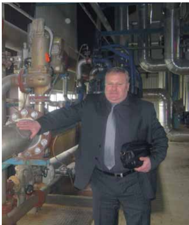
Rys. 14. Empiryczne sprawdzanie ciepła geotermalnego, Pyrzyce (fot. B. Igliński)
