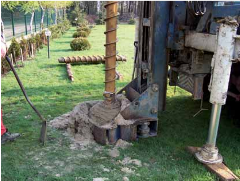
Rys. 9. Odwiert pod pionowy wymiennik gruntowy [10]
