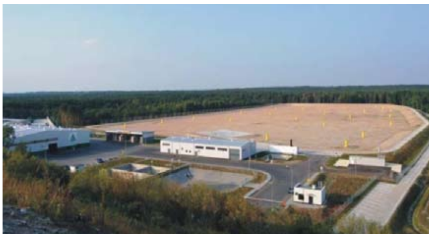
Rys. 4. Zakład Unieszkodliwiania Odpadów Komunalnych w Toruniu (wrzesień 2009 r.)
