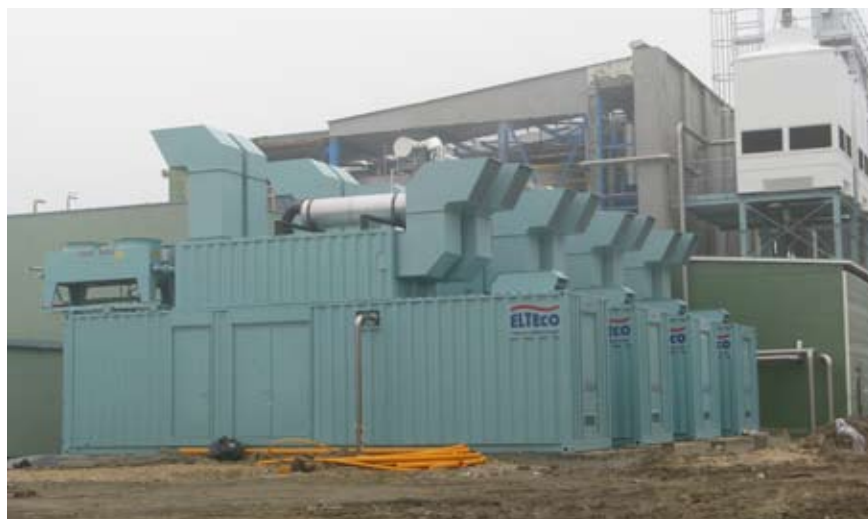
Rys. 2. Układy kogeneracyjne w Melnie (fot. B. Igliński)
