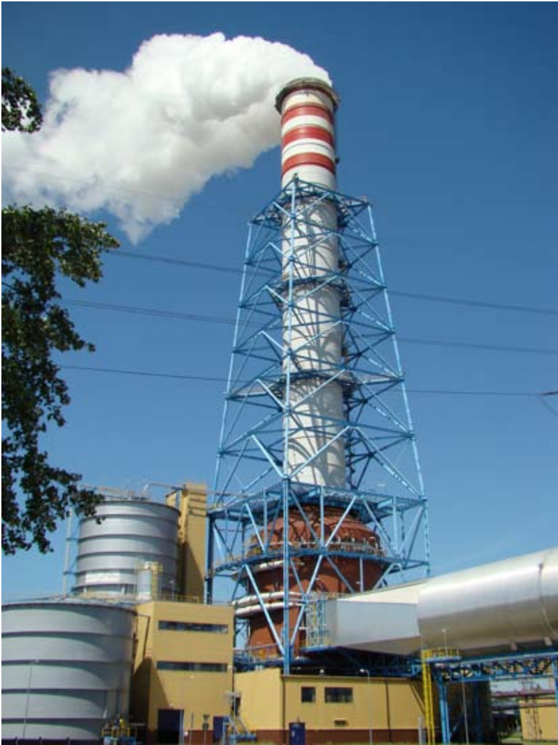
Rys. 3. Komin D_n 10100 mm, H=125 m (wylot) w instalacji odsiarczania gazów spalinowych w elektrowni na terenie Polski
