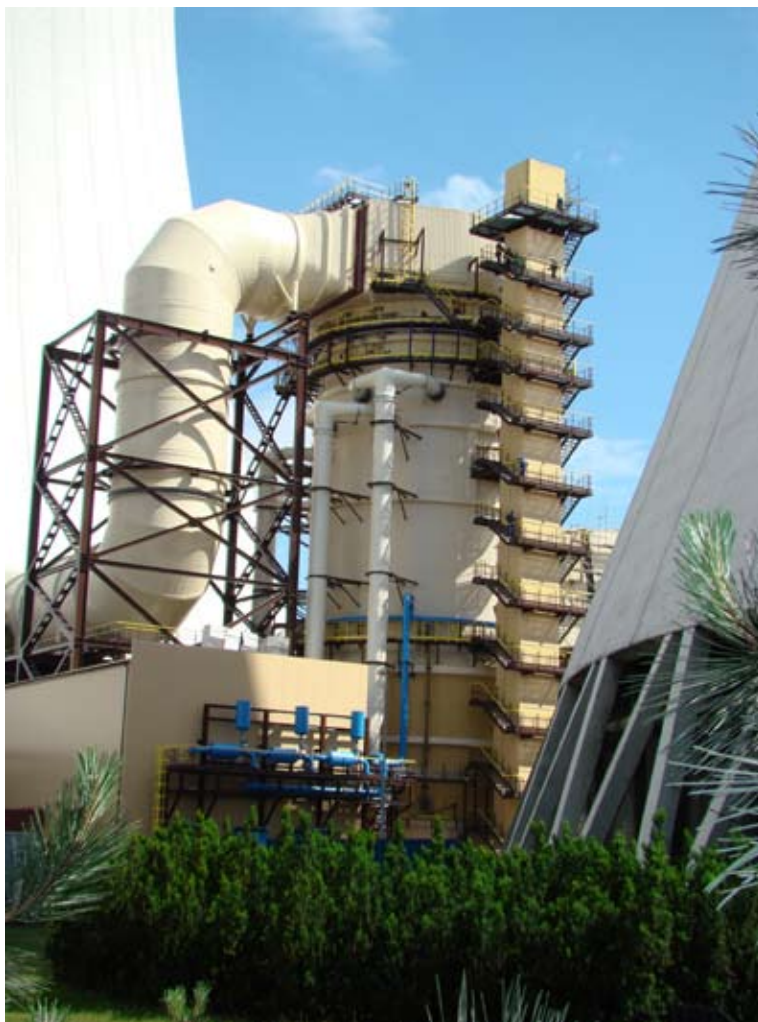
Rys. 2. Kanał spalin D_n 7000 mm z absorbera do chłodni kominowej w instalacji odsiarczania spalin w elektrowni na terenie Polski
