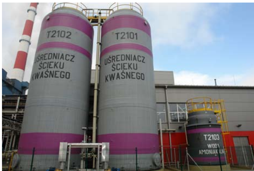
Rys. 1. Zbiorniki D_n 4000 mm, V=160 \text{ m}^3
