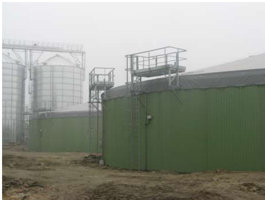
Rys. 1. Silosy na zboże (z lewej), komory fermentacyjne (z prawej) w Melnie (fot. B. Igliński)
