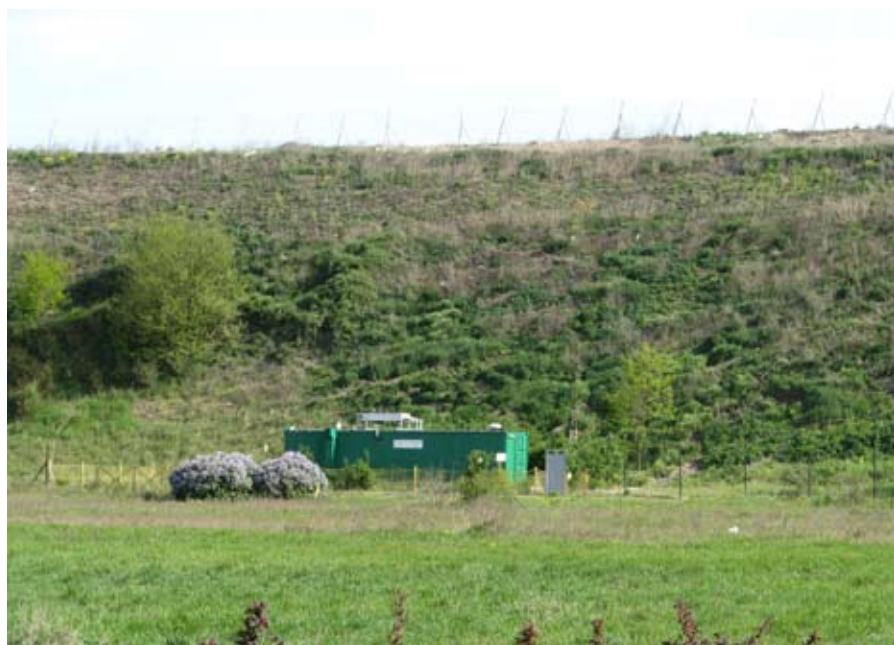
Rys. 1. Widok na MSO w Toruniu, na dole kontener z MPR-1 (fot. B. Igliński)
