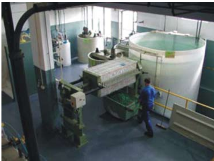
Rys. 5. Rozładunek prasy filtracyjnej
