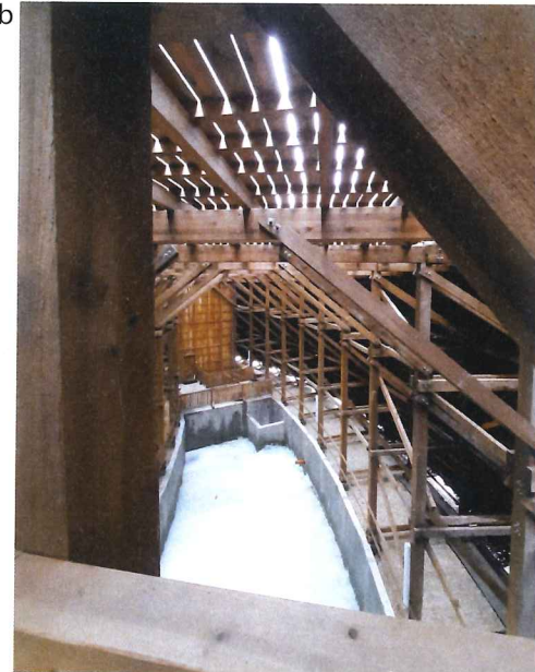
Fot. 2. a) tężnia i b) zbiornik na solankę tężniową w Busku-Zdroju (fot. A. Burkowska-But)
