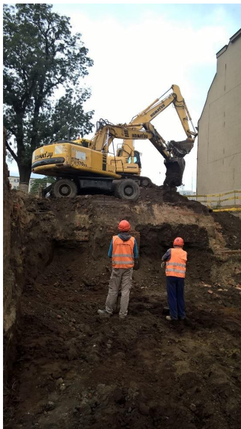
Ilustracja 5. Wykopaliska miejskie – prace z użyciem ciężkiego sprzętu.
