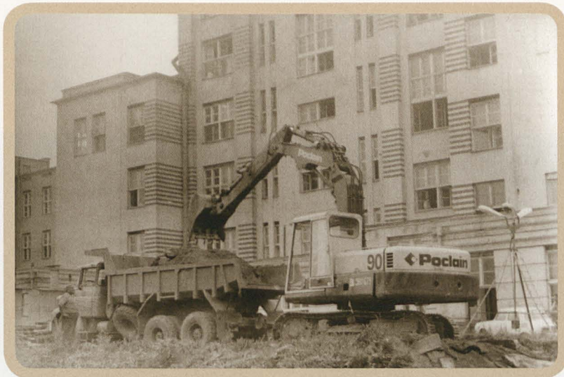
Bydgoszcz, początek budowy skrzydła operacyjno-diagnostycznego i czterech zakładów dydaktycznych Szpitala im. dra A. Jurasza, 1977.
