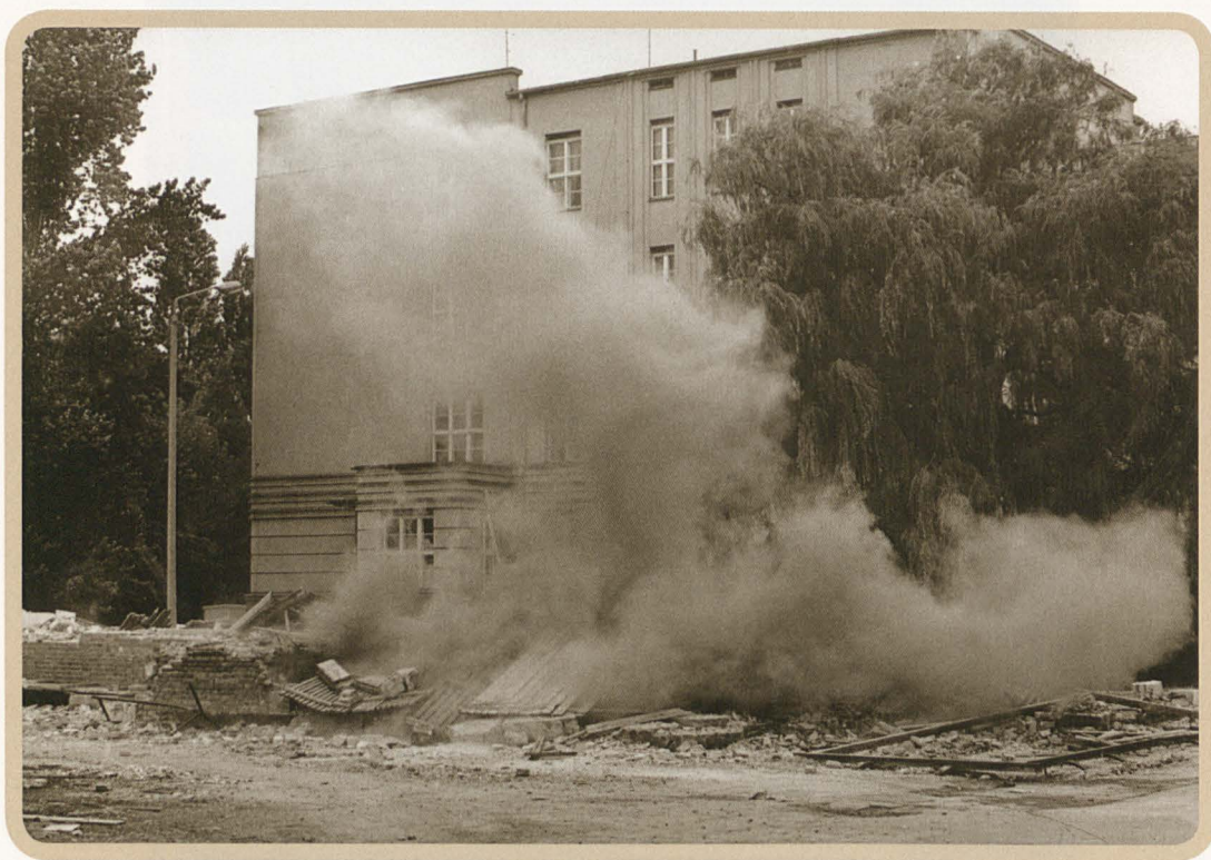
Bydgoszcz, saperzy wyburzają murowany barak, w miejscu którego powstanie budynek „starej patomorfologii”, 1 wrzesień 1975.
