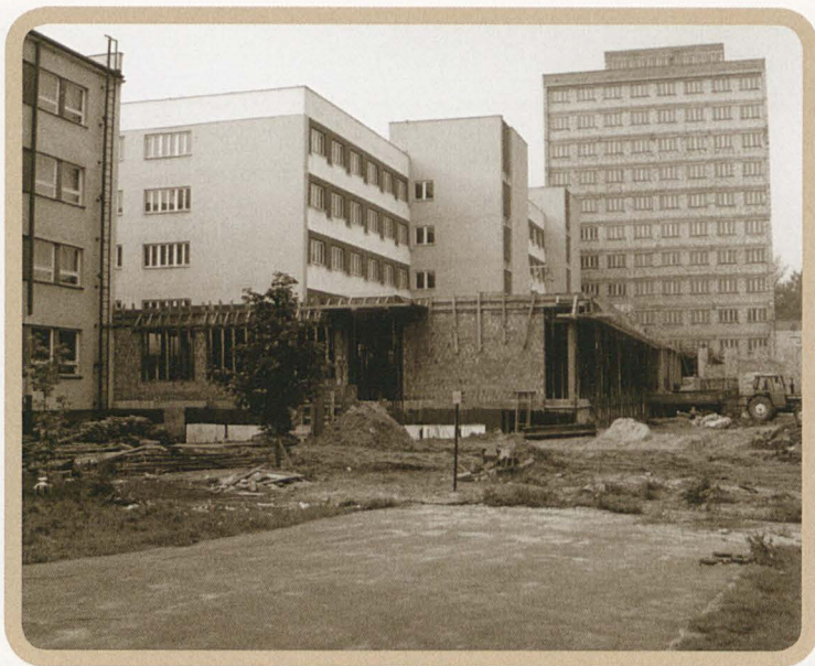
Bydgoszcz, początek budowy Kliniki Rehabilitacji Szpitala im. dra A. Jurasza, 1996.
