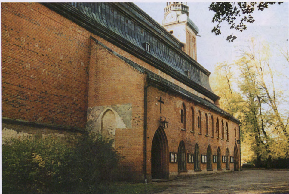
3. Kartuzy, kościół poklasztorny, (XIV w.), widok od strony północno-wschodniej. Widoczny fragment zamurowanego przejścia z kapitułarza do małego krużganka, stan z 1999 r.
