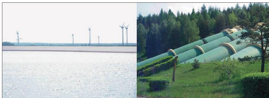
Rys. 8. Elektrownia szczytowo-pompowa w Żarnowcu; zbiornik górny i kanał rurociąg (fot. B. Igliński).
