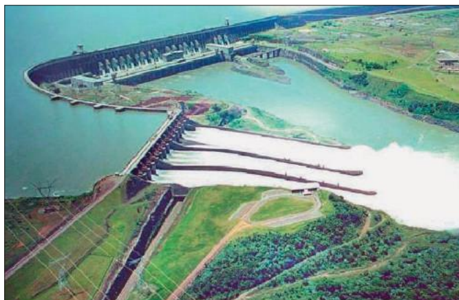
Rys. 13. Elektrownia Itaipu (zdjęcie: Angelo Leithold).
