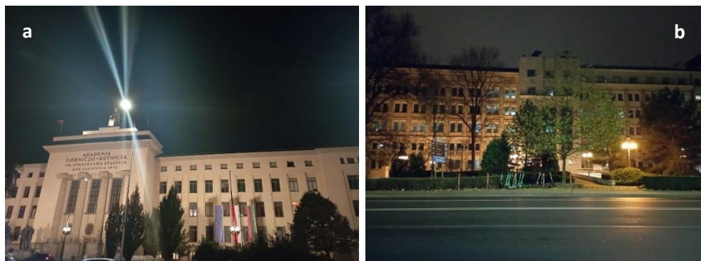
Ryc. 12. Czarna Wieś – Akademia Górniczo-Hutnicza, a) budynek A-0, b) budynek C-1 Centrum Energetyki (fot. Lidia Filipiak).
