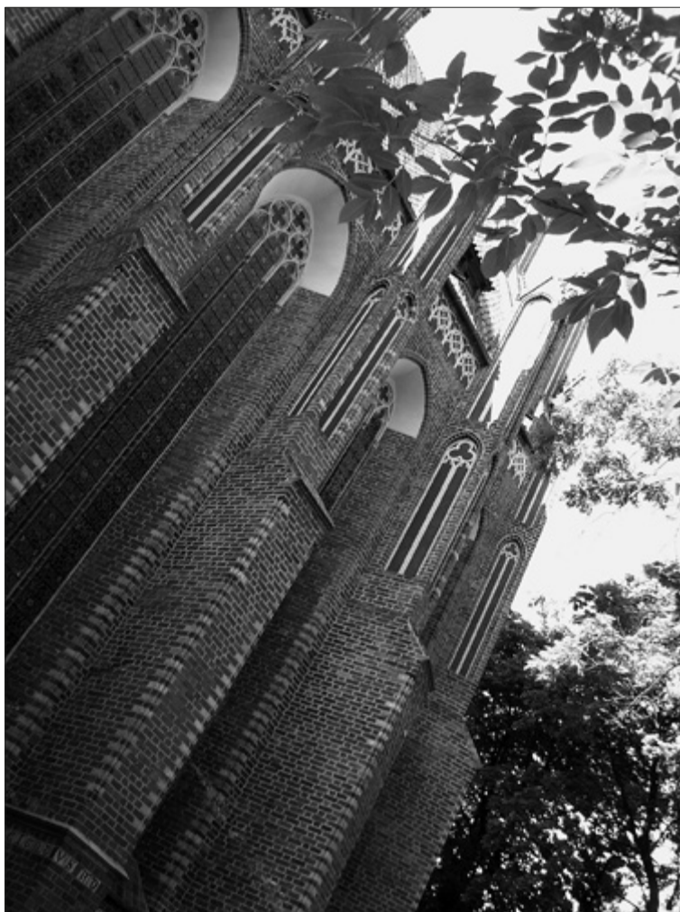
Ryc. 8. Toruń (stan. 360), kościół św. Jakuba. Elewacja prezbiterium od południa. Fot. A. Cicha
