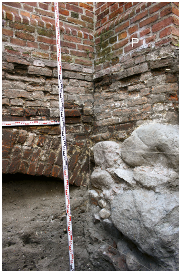
Ryc. 49. Toruń (stan. 360), kościół św. Jakuba. Wykop W-16/15. Widok od zachodu na styk wschodniej przypory P (nr 13) (po jej przedłużeniu) z arkadowym fundamentem kaplicy. Fot. J. Struwe
