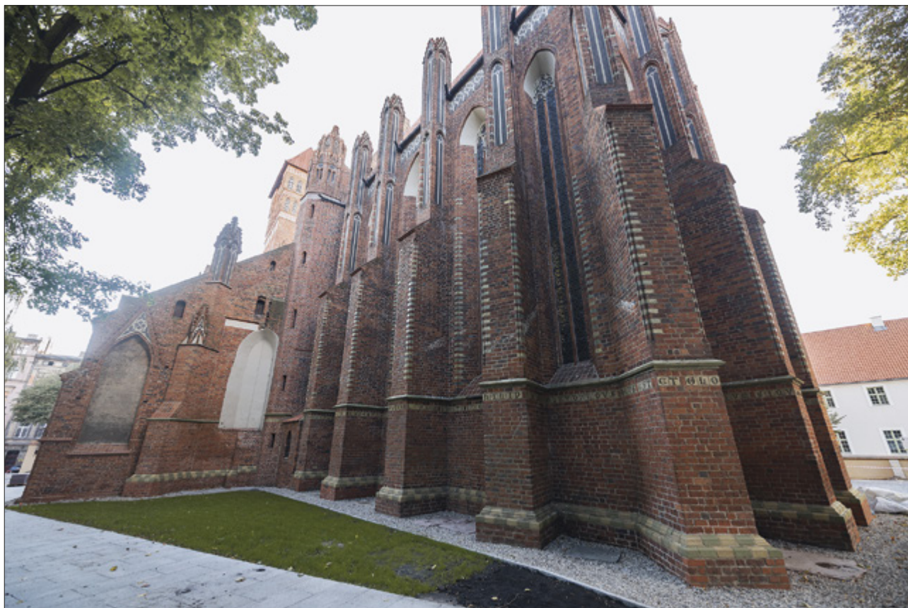
Ryc. 1. Toruń (stan. 360), kościół św. Jakuba. Bryła od południowego wschodu. W głębi wieża zachodnia (2021). Fot. W. Ochotny
