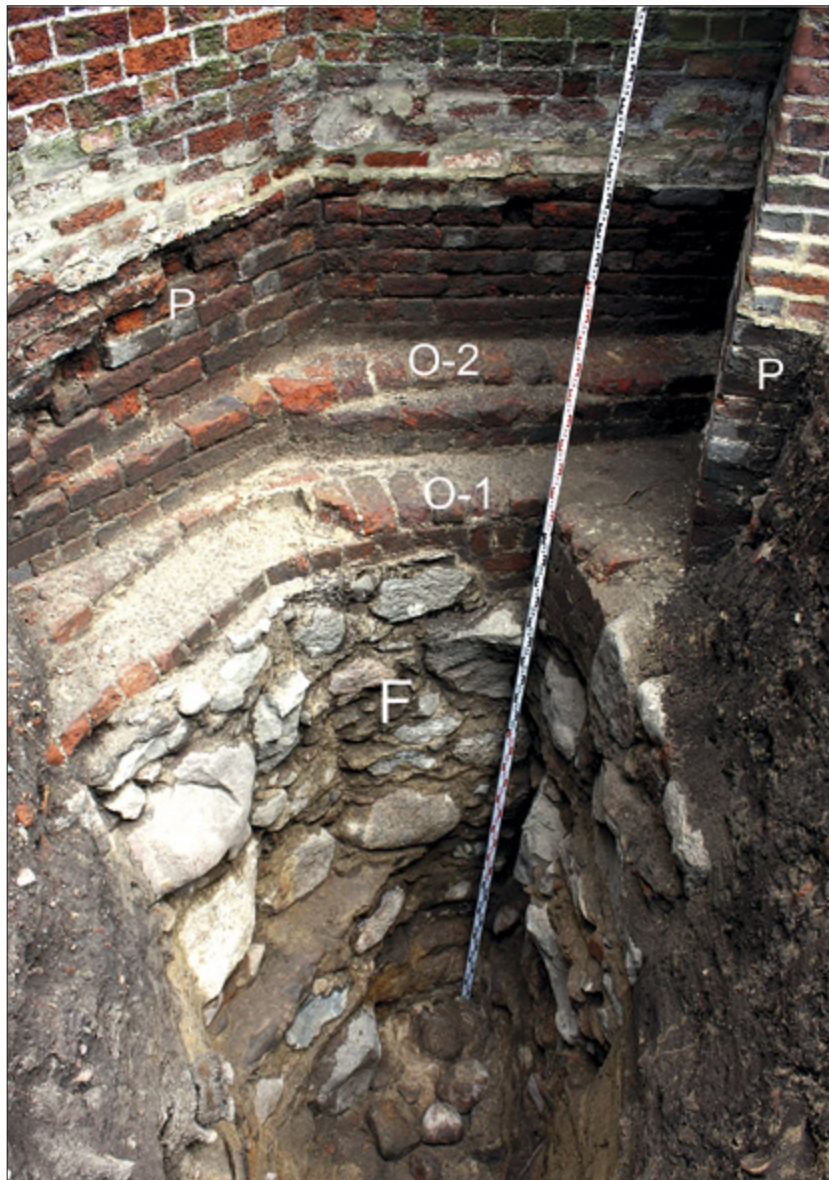
Ryc. 27. Toruń (stan. 360), kościół św. Jakuba. Kamienny fundament (F) pod narożnikiem północno-wschodnim prezbiterium (W-6/11). Widoczne dwie odsadzki (O1, O2). Po prawej przypora przekątniowa P (nr 3), na prostym fundamencie. Po lewej przypora przekątniowa P (nr 4) na skośnym fundamencie. Fot. J. Struwe
