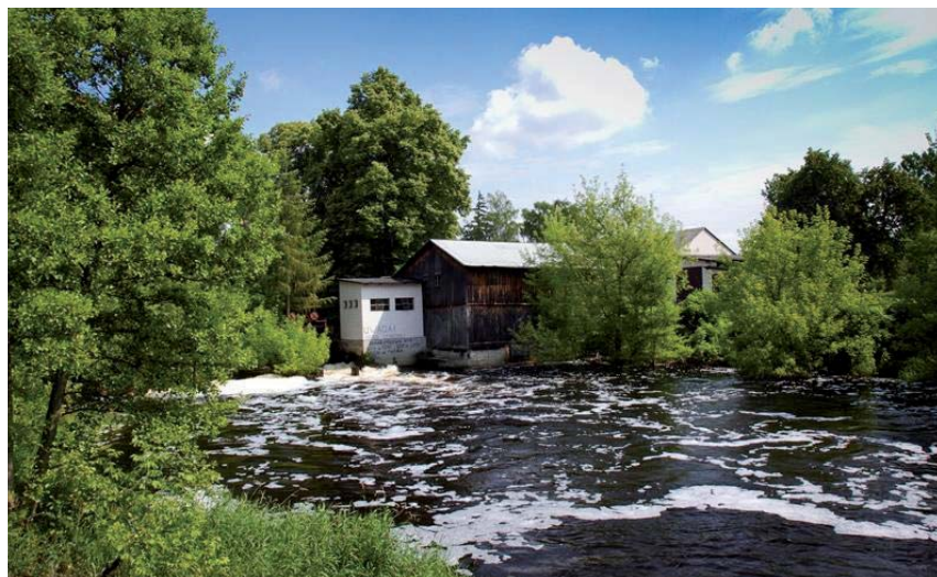
Rys. 5. Mała elektrownia wodna w Nowych Kozubach [11]
