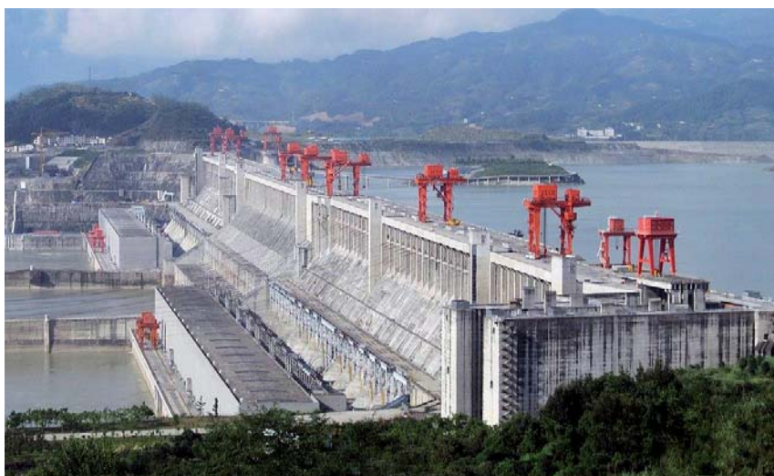
Rys. 2. Zapora Trzech Przełomów w Chinach (fot. R. Rehman)
