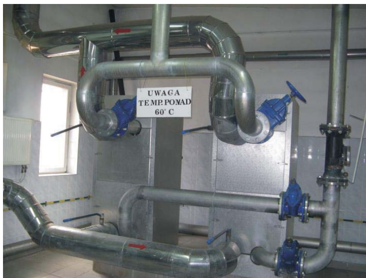
Rys. 6. Wymienniki ciepła, Uniejów (fot. B. Igliński)
