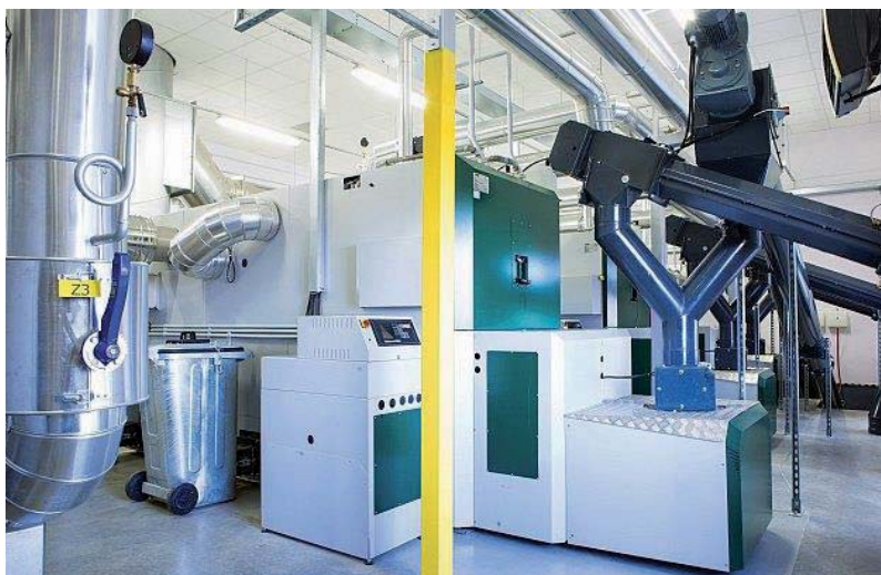
Rys. 3. Kaskada kotłów na biomasę w Złoczewie (fot. B. Dziamski) [7]
