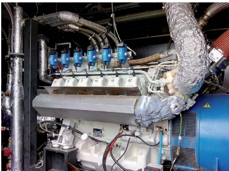
Rys. 7. Silnik kogeneracyjny w biogazowni w Sobawinach (fot. B. Igliński)
