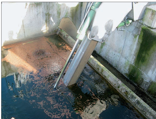
Rys. 19. Oczyszczanie wody z zanieczyszczeń „grubych” przy małej elektrowni wodnej (fot. B. Igliński)
