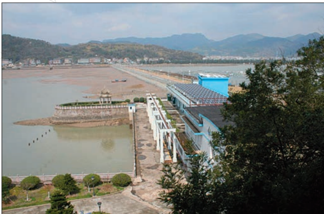
Rys. 8. Elektrownia pływowa zlokalizowana w mieście Jiujiang (Chiny) [15]
