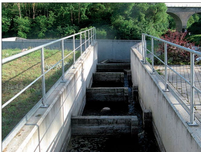
Rys. 18. Przepławka dla ryb przy małej elektrowni wodnej (fot. B. Igliński)
