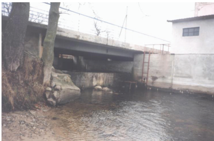
Ryc. 26. Mała Elektrownia Wodna w Nowej Wsi Ełckiej [47]
