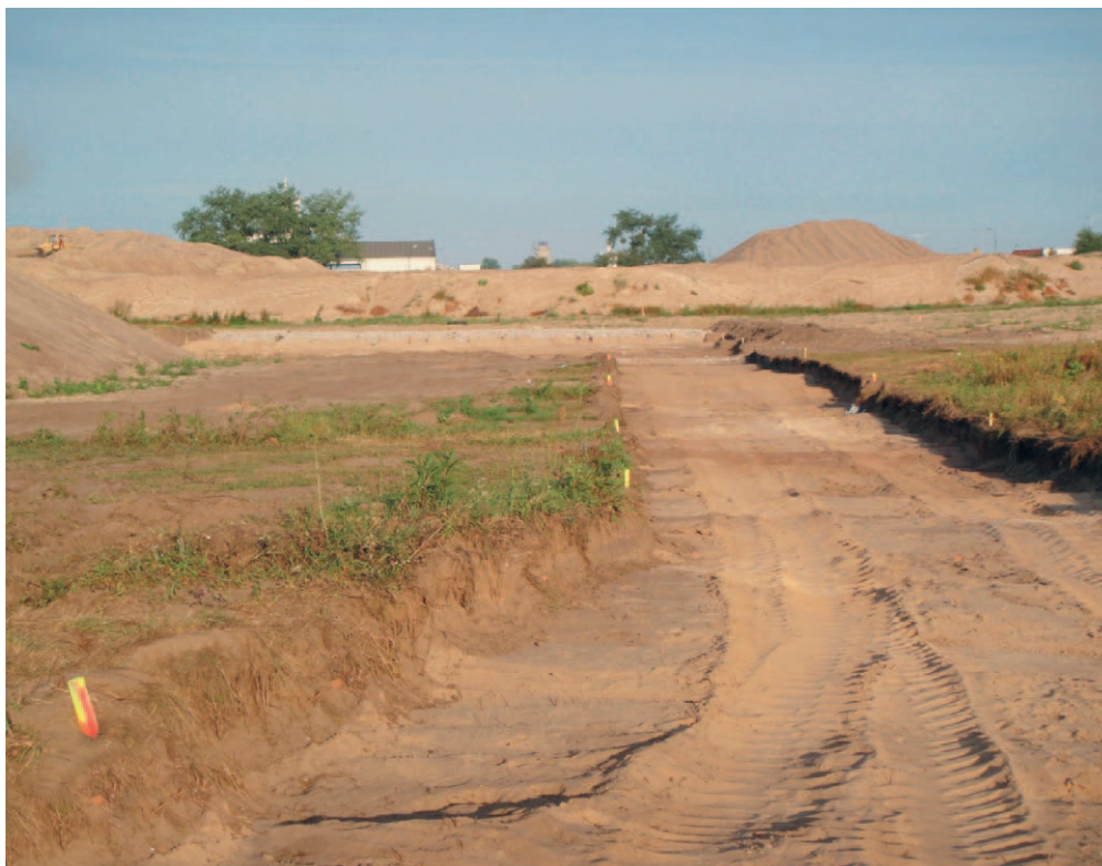
Il. 14. Gruntowe drogi dojazdowe do miejsca posadowienia wiatraka (fot. K. Bąk)
