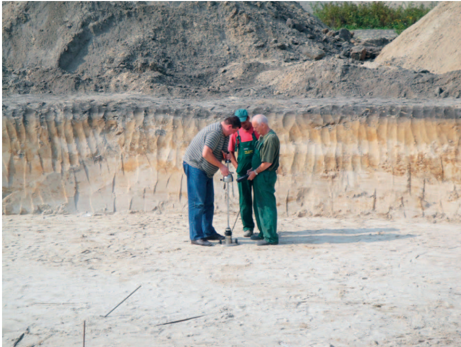
Il. 15. Wykop pod fundament ze zbrojonego betonu (fot. K. Bąk)
