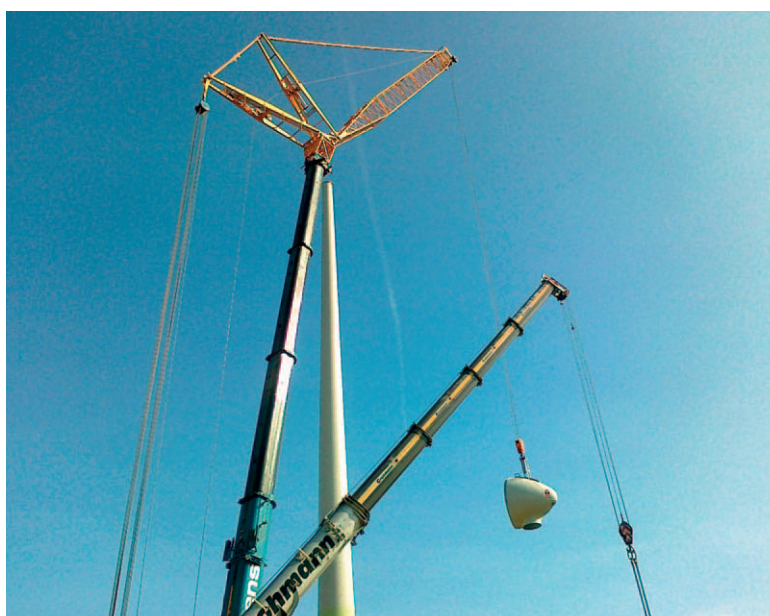
Il. 18. Montowanie gondoli (fot. K. Bąk)
