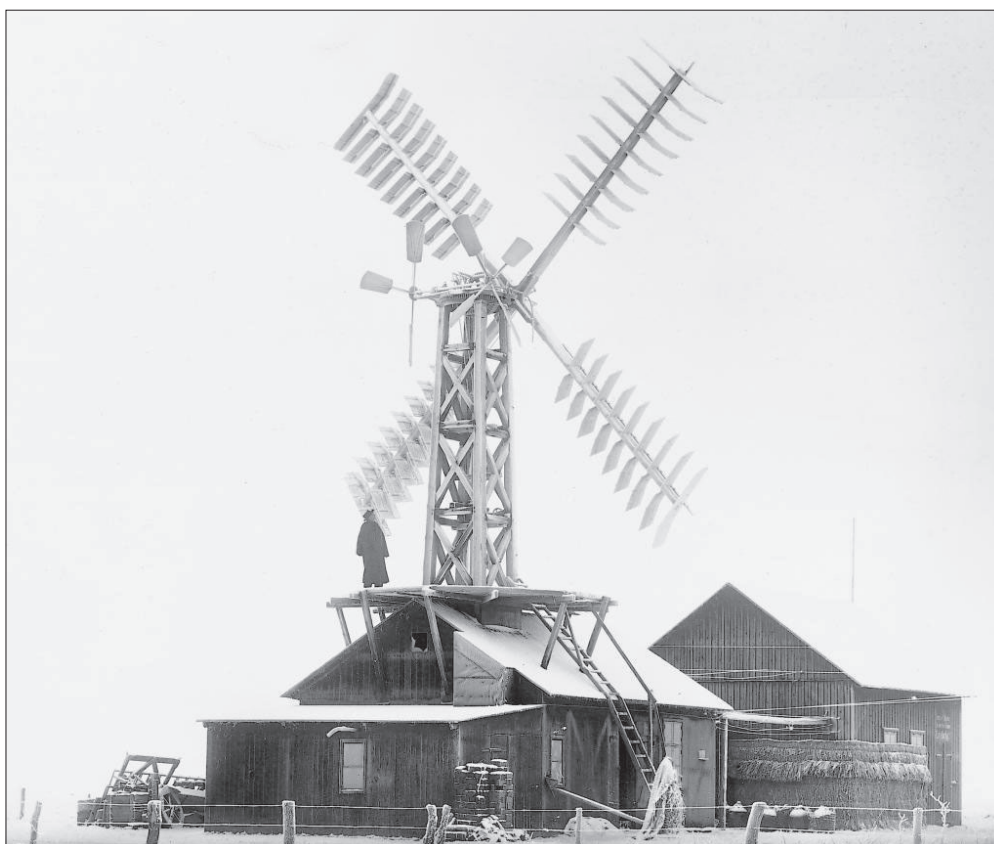
Il. 2. Pierwsza turbina zbudowana przez Poula la Cour [9]
