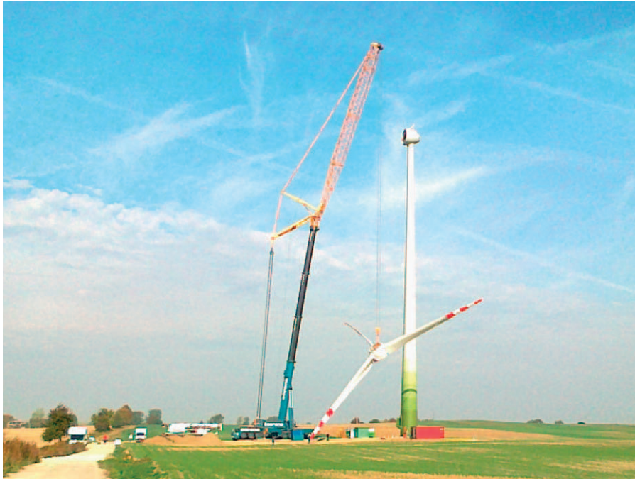
Il. 19. Montowanie wirnika (fot. K. Bąk)
