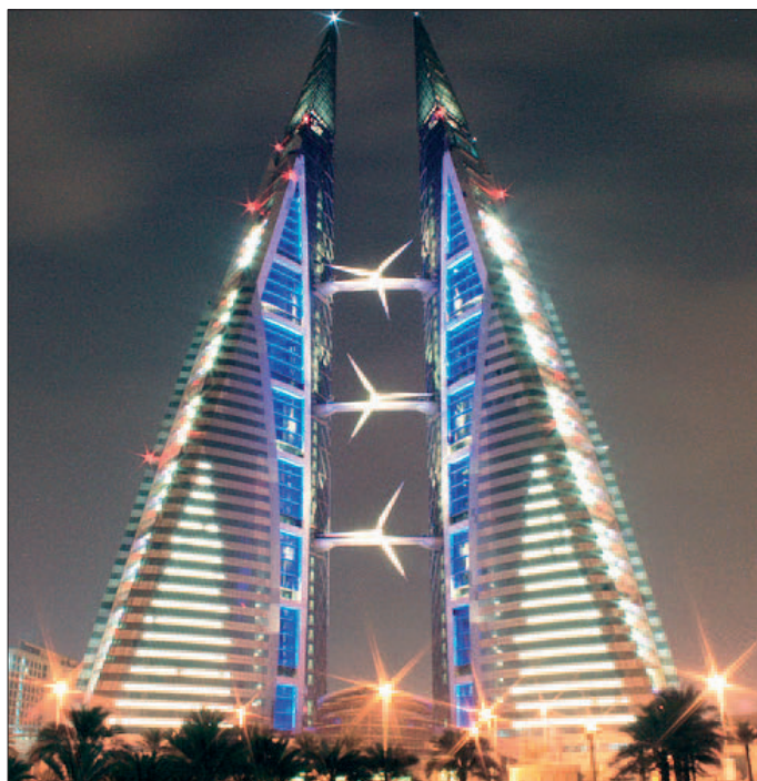
Il. 17. Turbiny wiatrowe zainstalowane w Światowym Centrum Handlu w Bahrajnie [31]
