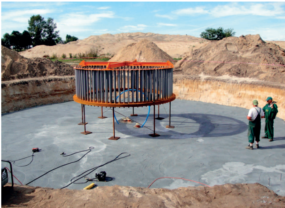
Il. 16. Fundament pod elektrownię wiatrową (fot. K. Bąk)
