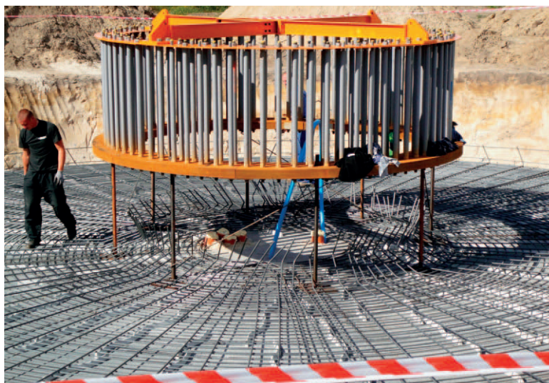
Il. 17. Zbrojenie fundamentu pod elektrownię wiatrową (fot. K. Bąk)
