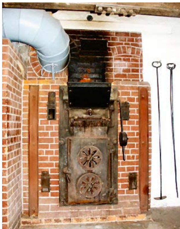
Rys. 25. Piec opalany wytłuszczonymi szyszkami w Rucianem-Nidzie [45]
