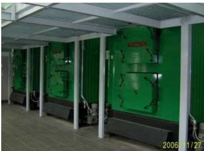
Rys. 18. Miejska kotłownia w Bornem Sulinowie [36]
