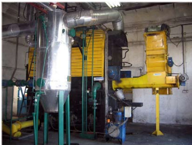
Rys. 23. Kotłownia na słomę w Nowych Skalmierzycach [36]
