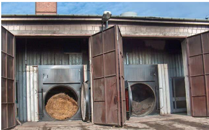
Rys. 24. Kotłownia na słomę w Grabowcu [35]
