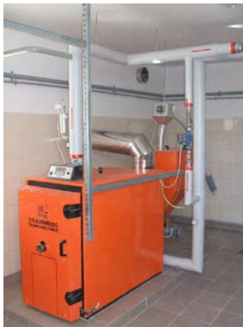
Rys. 26. Kotłownia opalana ziarnem owsa w Piekoszowie [35]
