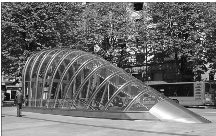
Ryc. 2. Wejście do jednej ze stacji metra w Bilbao zaprojektowanej przez pracownię Normana Foster'a
