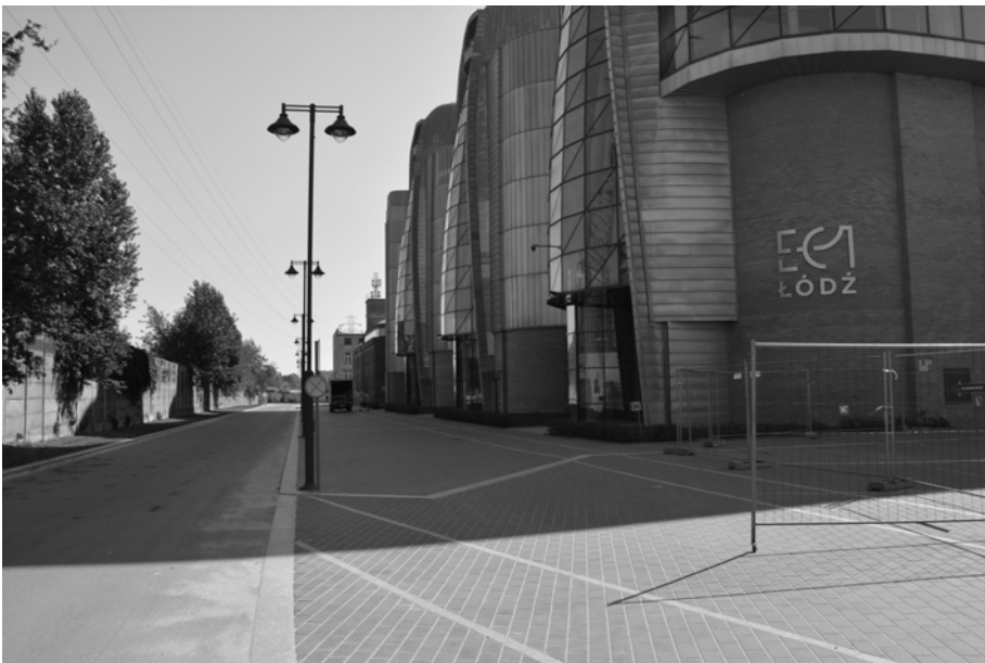
Ryc. 73. Dobre skadrowanie „Vaderów” było wyzwaniem ze względu na płot budowy (po lewej) i metalowe przenośne ogrodzenia (po prawej)
