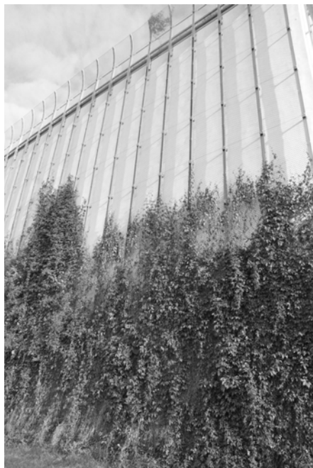
Ryc. 45. Bluszcz rosnący na ścianie gmachu
