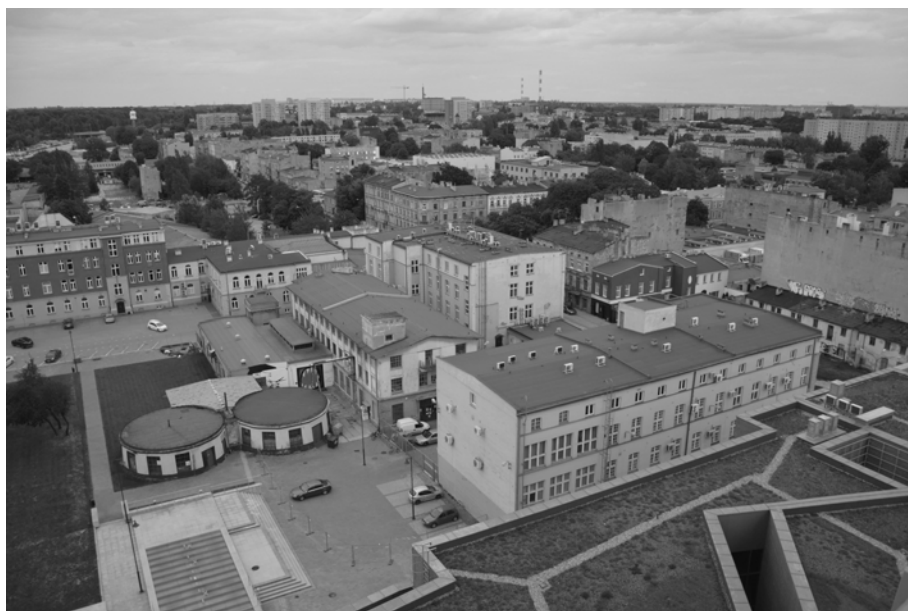
Ryc. 68. Widok EC1 Południowy Wschód z dachu wieży chłodniczej EC1 Zachód, a w tle łódzka zabudowa nieobjęta jeszcze gentryfikacją
