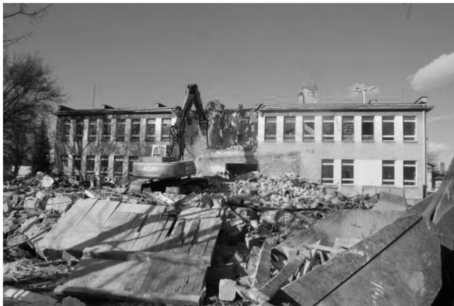
Ryc. 26. Wyburzanie starego WCK w 2010 r.
