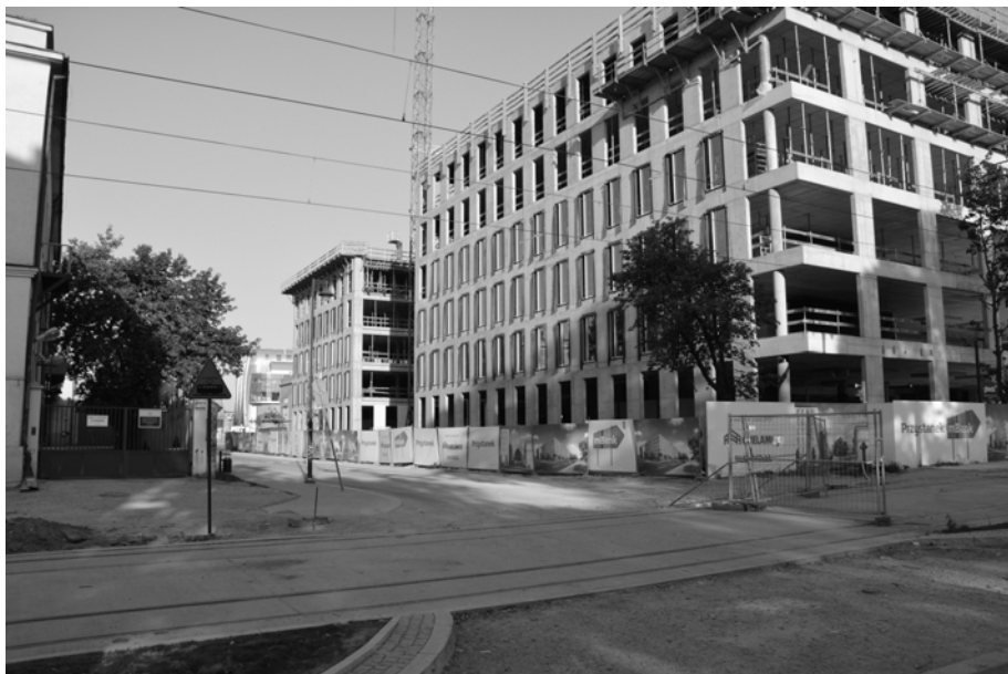
Ryc. 72. Przystanek mBank w budowie
