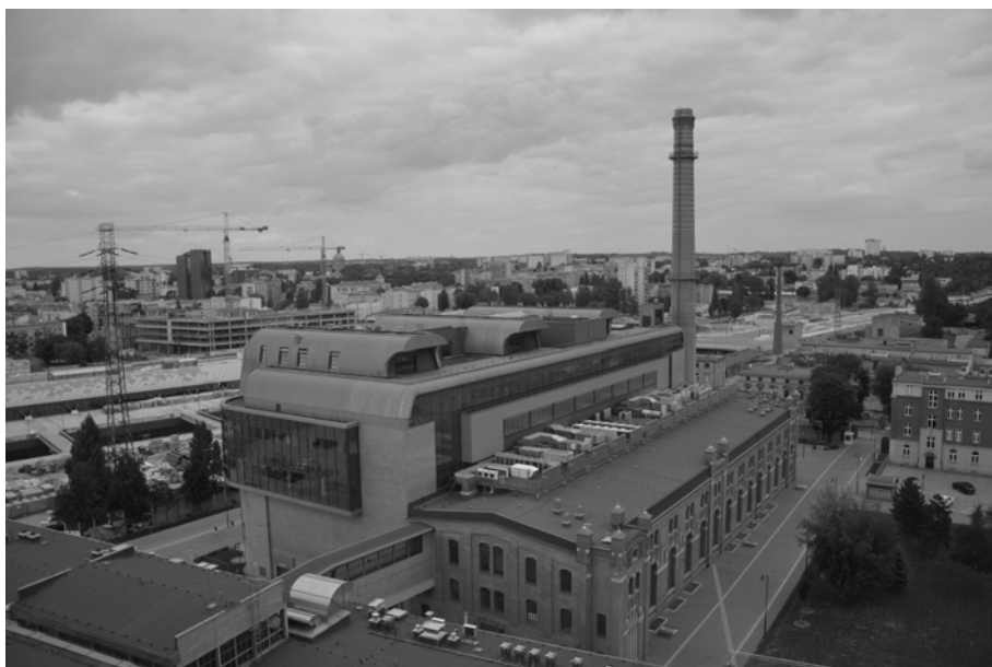
Ryc. 66. Widok EC1 Wschód z wieży chłodniczej przynależącej do EC1 Zachód
