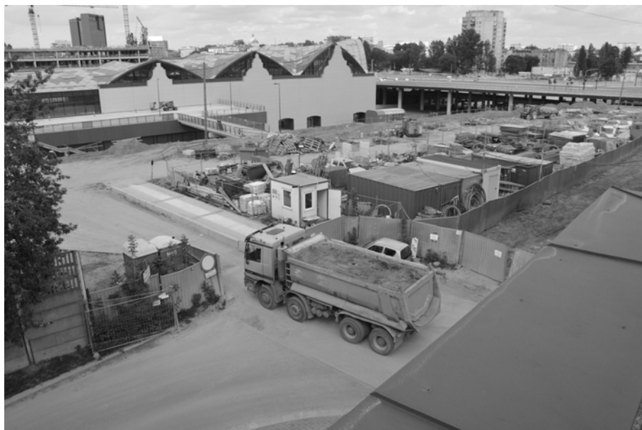
Ryc. 71. Widok roztaczający się z dachu na plac budowy (stan z czerwca 2016 r.)
