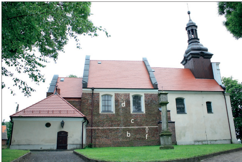
4. Późnoromański kościół w Tulcach. Elewacja północna. Oprac. Maciej Prarat, Karolina Zimna-Kawecka, 2014
