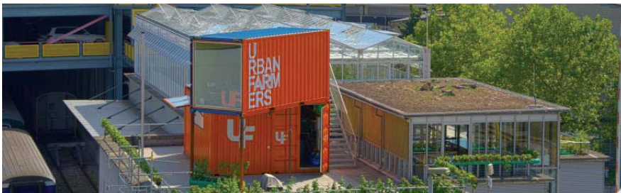
Rycina 45. Mikrofarma na dachu budynku, Bazylea (Szwajcaria)
