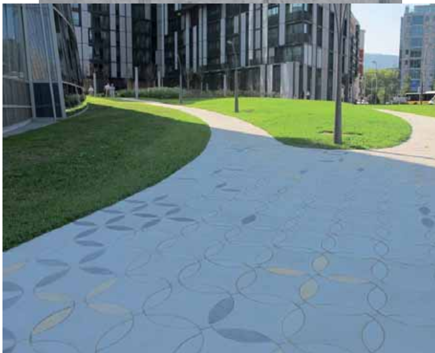
Ryc. 61. Płyta zawierająca GeoSilex pochłaniający \text{CO}_2 z atmosfery
