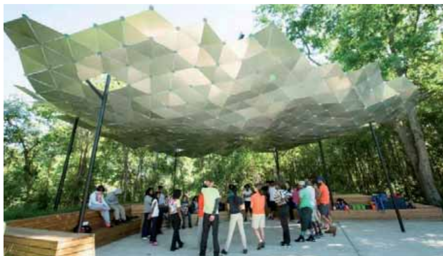
Ryc. 63. Altana zbudowana ze starych znaków
