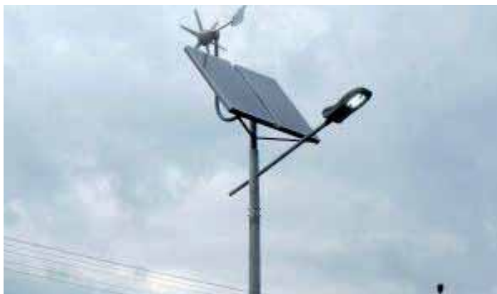
Ryc. 60. Latarnia zasilana energią ze źródeł odnawialnych
