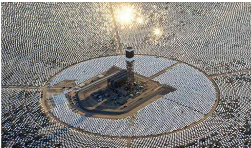
Ryc. 14. Fragment elektrowni słonecznej w Ivanpah w Kalifornii (USA).
