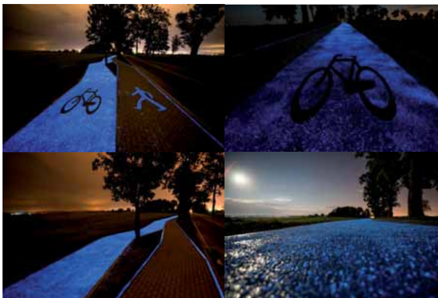
Ryc. 58. Ścieżka rowerowa wykonana z materiałów luminescencyjnych, woj. warmińsko-mazurskie, Polska
