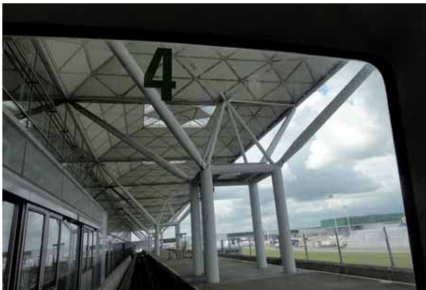
Ryc. 28. Stansted Airport Transit System – w pełni zautomatyzowany system transportu łączący terminal główny z dwoma innymi na lotnisku Stansted
