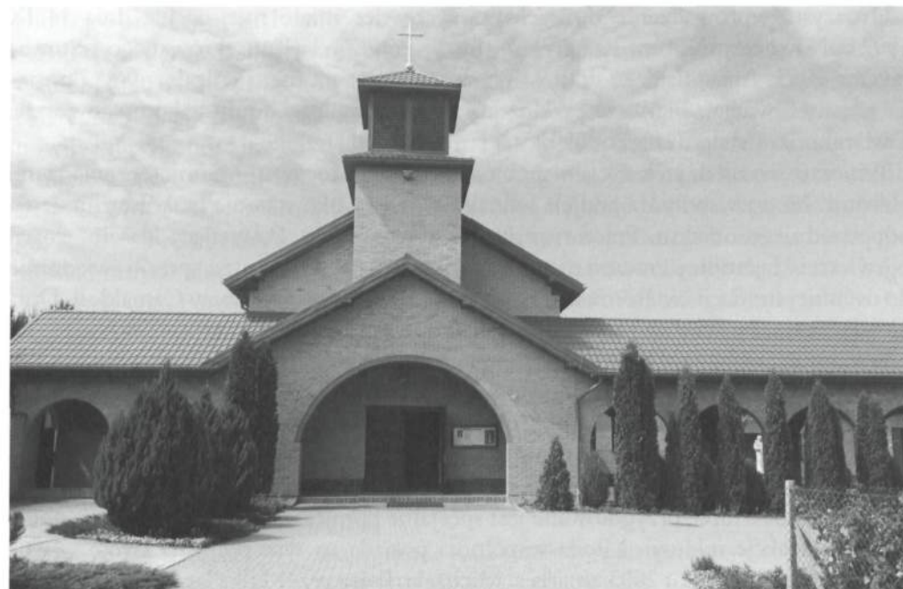
Fot. 9. Klasztor w Tyszowcach, widok od strony kaplicy (AKMKZ)
