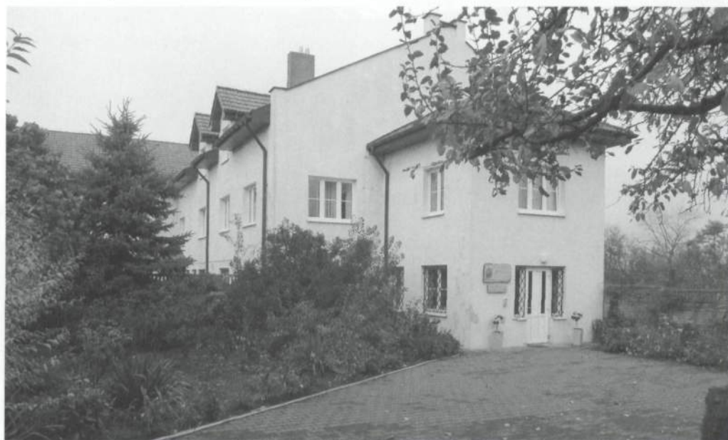
Fot. 6. Dom Rekolekcyjny - Pustelnia św. Romualda (AKMKZ)
