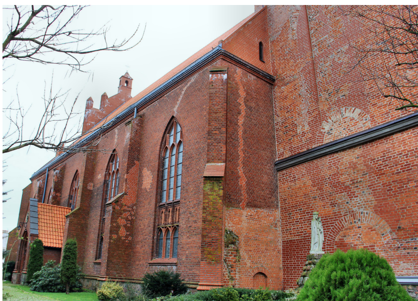
Il. 16. Wolin, kościół pw. św. Mikołaja. Ściana północna, 2014. Fot. J. Gierłasiński
