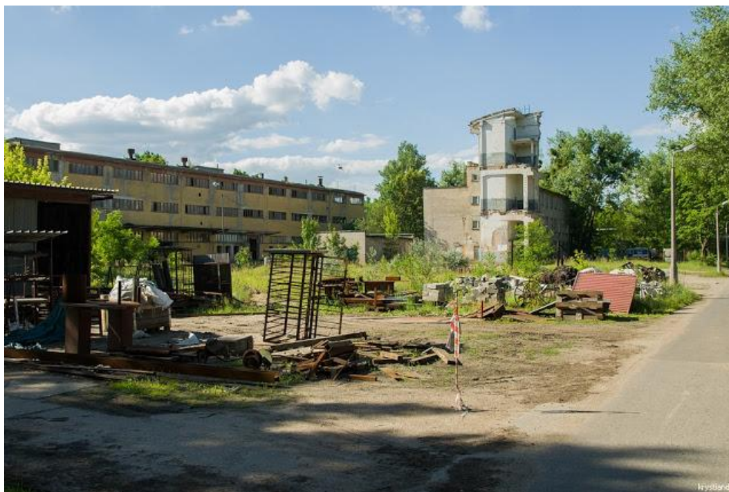
Ryc. 62. Obiekty byłych Zakładów Chemicznych ZACHEM
