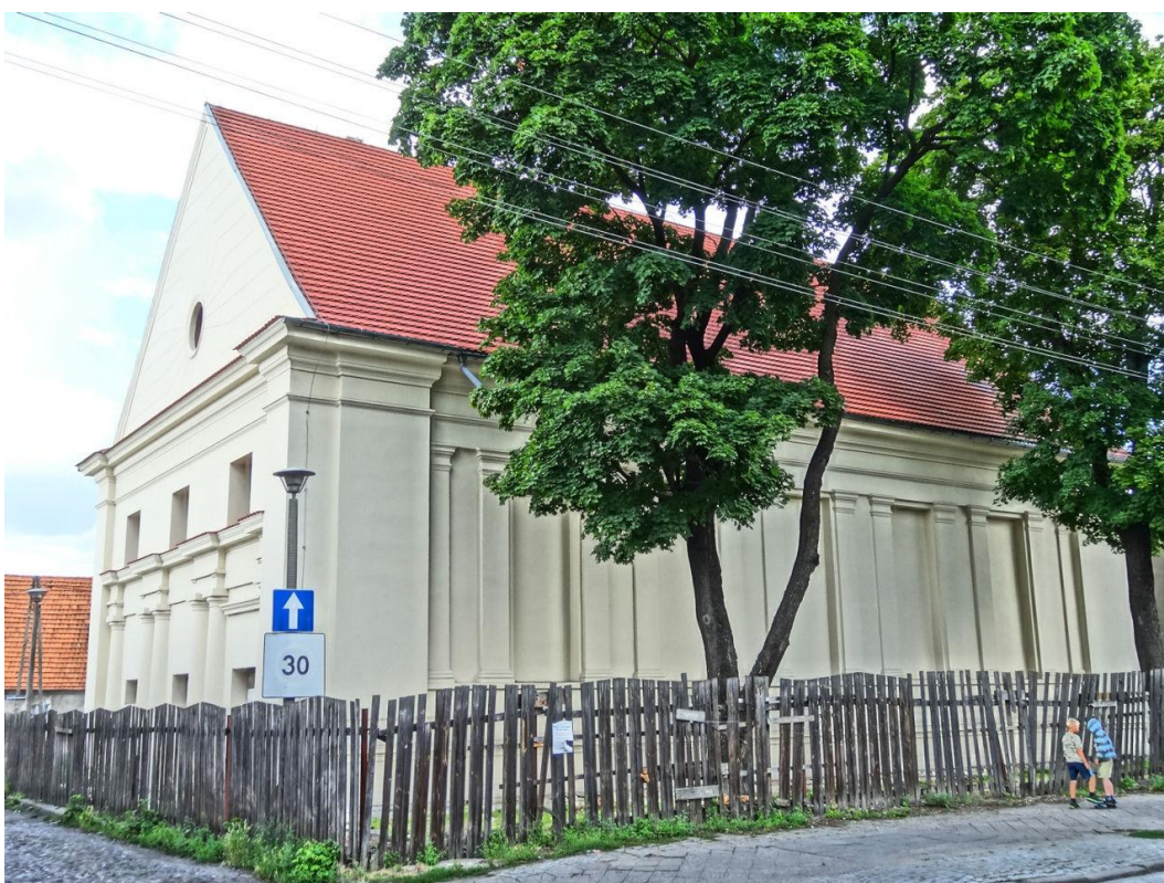
Ryc. 48. Zabytkowy budynek Synagogi w Starym Fordonie
