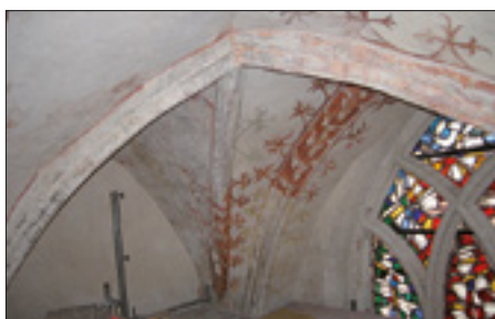
Fot. 11. a, b, c. Dekoracje żeber sklepiennych; sklepiennych: a) w chórze kościoła św. Jakuba, b) w chórze kościoła św. Jakuba, c) w krużganku kościoła Wniebowzięcia NMPanny, d) na sklepieniu nawy północnej kościoła św. Janów w Toruniu, fot. I. Bulderberg, M. Musiela, I. Brzostowska
