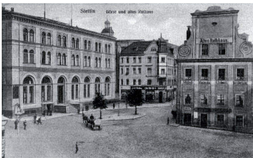
Il. 16. Rynek Sienny (Heumarkt), budynek Giełdy, Stary Ratusz, pocz. XX w. (fot. zamieszczono dzięki uprzejmości portalu Miłośników Dawnego Szczecina – sedina.pl)
