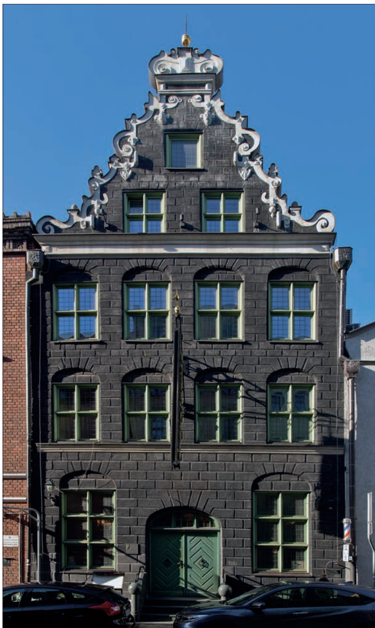
Il. 4. Kamienica przy ul. Małe Garbary 7 w Toruniu. Fot. A. Kola, 2019
