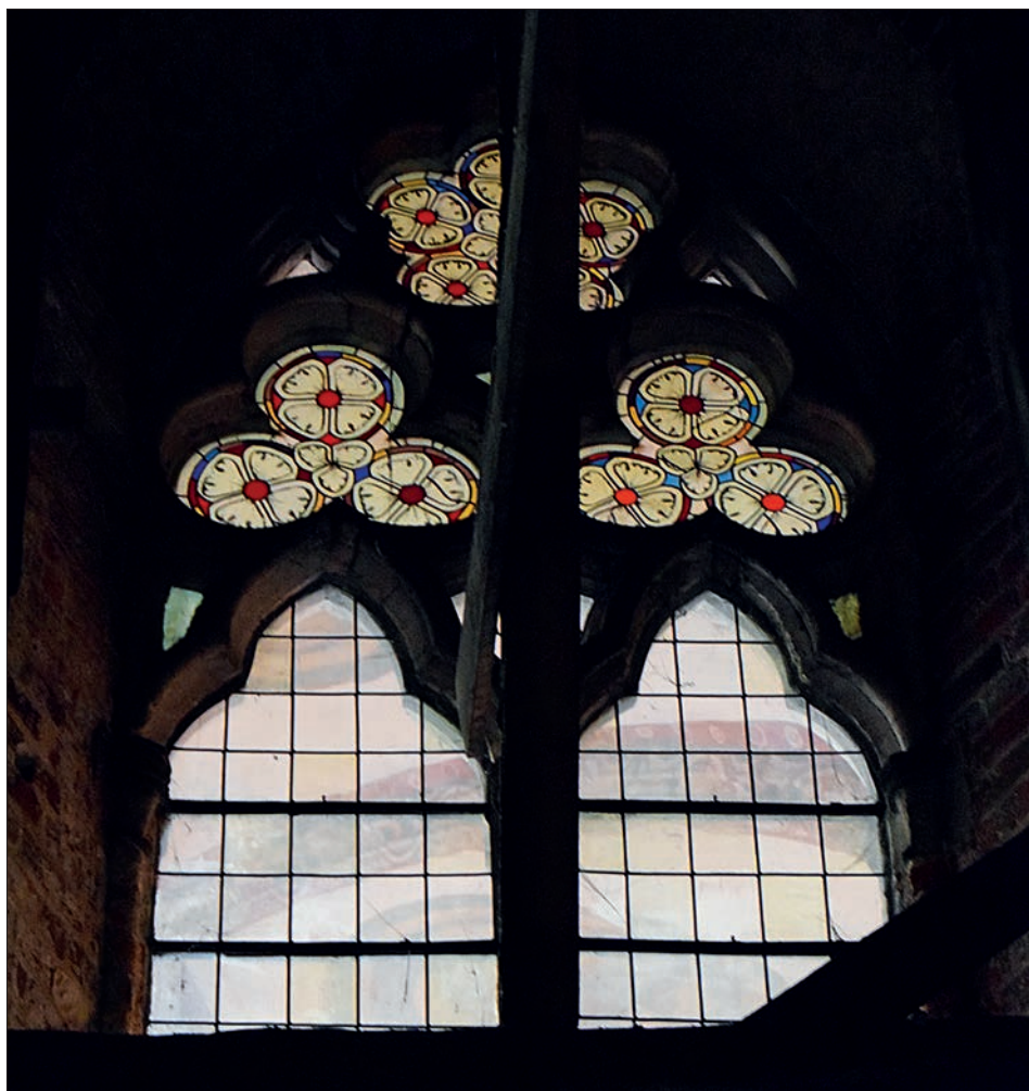
Il. 10. Witraż drugiego okna od wschodu po stronie północnej w prezbiterium z fragmentami oszklenia średniowiecznego (dwa dolne trójliscie). Fot. A. Kaźmierczak
