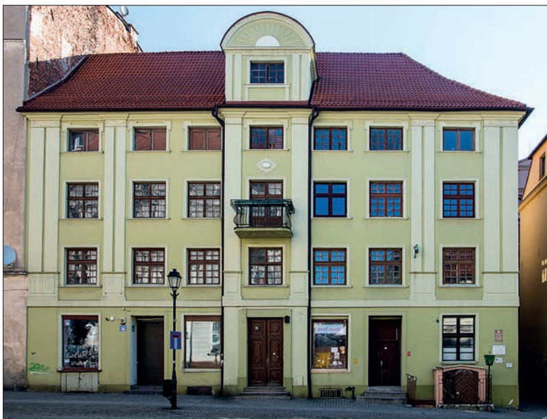
II. 8. Pałac Fengerów, ul. Mostowa 14 w Toruniu. Fot. A. Kola, 2019
