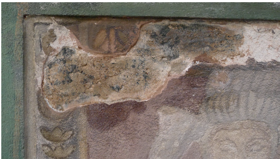
Fot. 4. Gdańsk, kamienica przy ul. Długiej 1. Fasada, lewy górny róg malowidła nad prawym oknem parteru po usunięciu wtórnego uzupełnienia zaprawy. Widoczne resztki ciemnoniebieskiej warstwy malarskiej i plecionka w centralnej części odsłoniętego fragmentu. Fot. Anna Żychska
