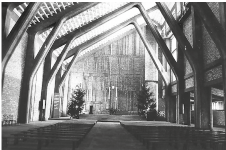
Wnętrze kościoła po ukończeniu prac budowlanych
