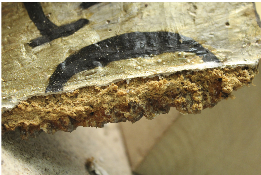
6. Dzierzgoń, kościół pw. Trójcy Przenajświętszej. Ołtarz północny. Miejsce pęknięcia szarfy z napisem GLORIA IN EXCELSIS DEO . Widoczna na zdjęciu żywica to kopalina, której roztworem w trakcie wcześniejszych prac impregnowano drewno. Fot. K. Szczepińska
