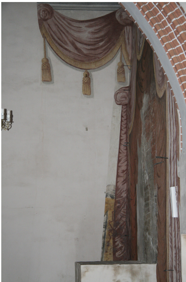
9. Dziergoń, kościół pw. Trójcy Przenajświętszej. Północno-wschodni narożnik kościoła. Kotara ze ściany tęczowej przechodzi na ścianę północną. U góry, pod stropem, ucięta forma jednoznacznie wskazuje na kontynuację malowidła. U dołu widoczny fragment dolnego pasa dekoracji, obecnie trudny do zinterpretowania. Zdjęcie wykonane po zakończeniu prac przy malowidle, przed montażem ołtarza. Fot. K. Szczepińska
