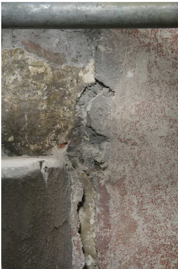
8. Dziergoń, kościół pw. Trójcy Przenajświętszej. Fragment wcześniejszego tynku, sprzed 1730 r., z zielonkawym opracowaniem malarskim, zachowany po prawej stronie mensy ołtarza północnego – za nim i w miejscu ubytku warstw osiemnastowiecznych. Fot. K. Szczepińska
