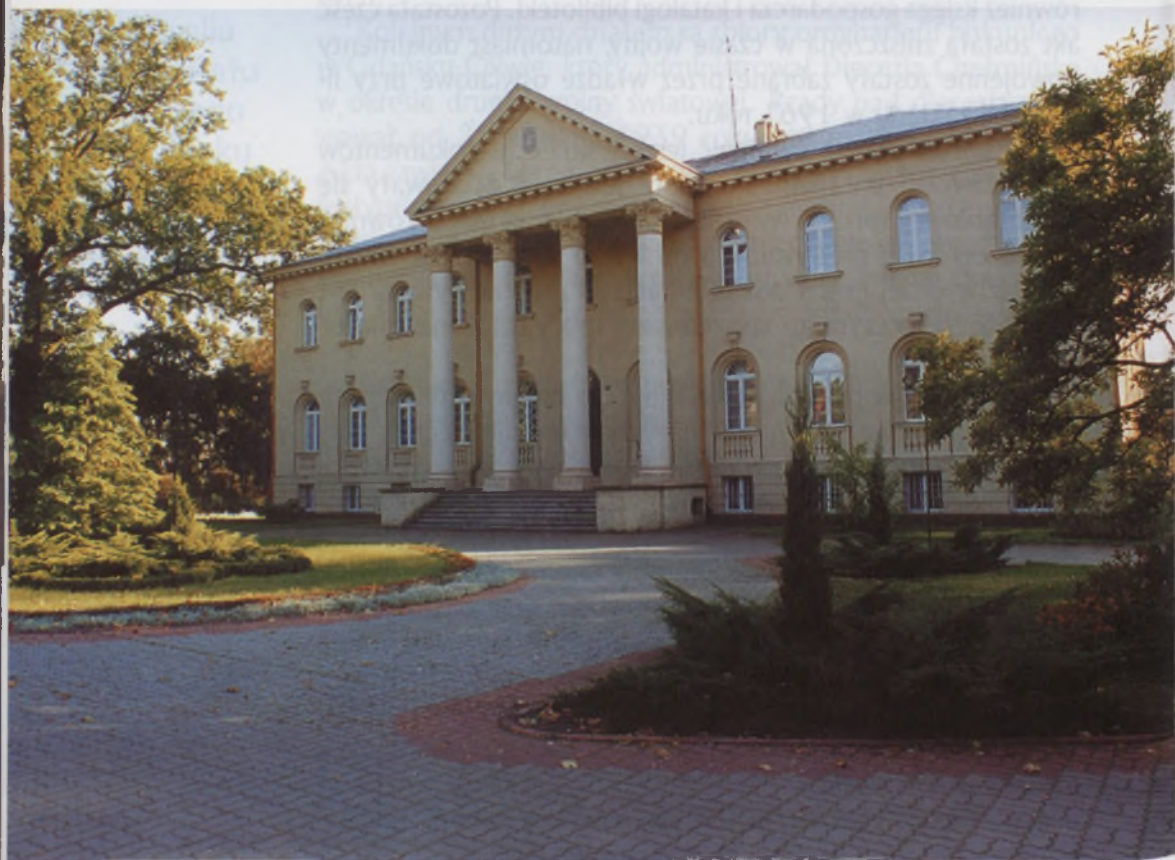
Pałac biskupi, 1837 r., neoklasycystyczna przebudowa w latach 1927-1928. Stan obecny po odnowieniu
