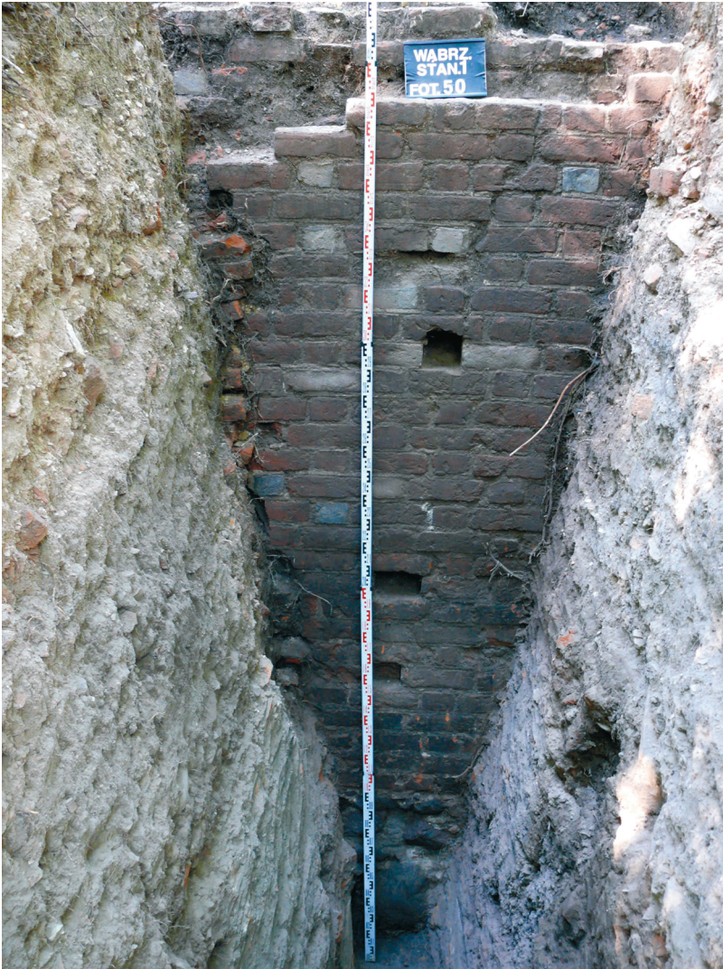
Ryc. 14. Wąbrzeźno, gm. loco. Lico muru parchamu na zamku (fot. M. Wiewióra)
