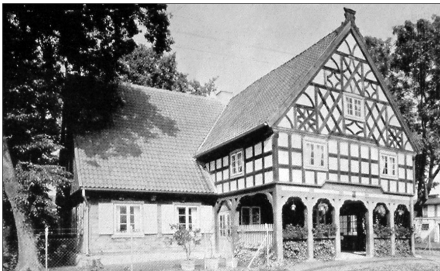
Il. 6. Klawki, dom podcieniowy z końca XVIII w. po przeprowadzonych pracach konserwatorskich ( Die Denkmalpflege in Westpreußen in den Jahren 1936 bis 1940. Von Dr. Bernhard Schmid, Provinzialkonservator für den Regierungsbezirk Westpreussen, Königsberg 1940, Abb. 8 )
