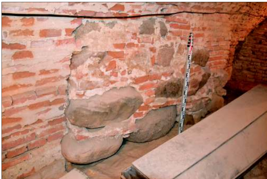
Ryc. 5. Fundament prezbiterium w cianie przedsionka krypty zachodniej (fot. M. Majorek)
