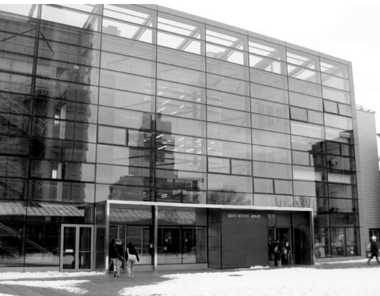
Ryc. 9. Elewacja David Wilson Library. Źródło: NotFromUtrecht.
